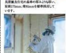
長尺断熱材の標準の厚みより厚い、厚径175mm、厚80mmを標準採用しています。
